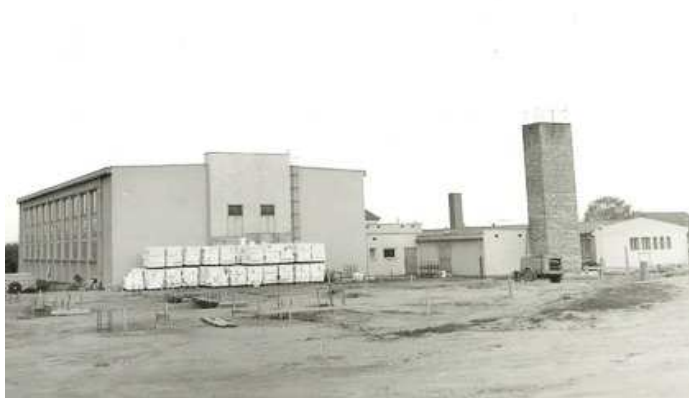
Začátek výstavby nové školy - 1986
